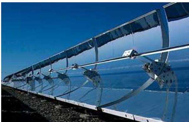
Figure 1 : capteur cylindro parabolique
