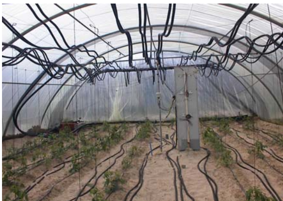
Figure 1. Echangeur de type agrotherm suspendu dans la serre
