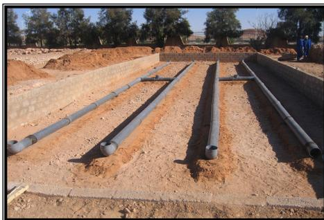
Figure 3 : Installation des conduites
