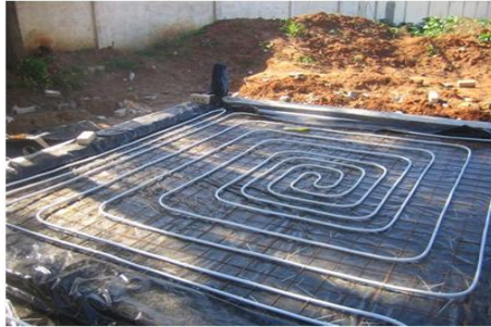
Figure 4 : Pose du serpentin (chambre 1)
