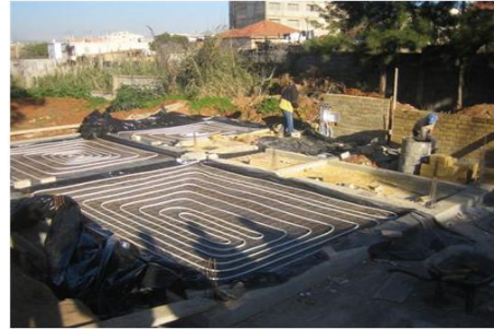
Figure 5 : Pose du serpentin sur l'ensemble de la maison
