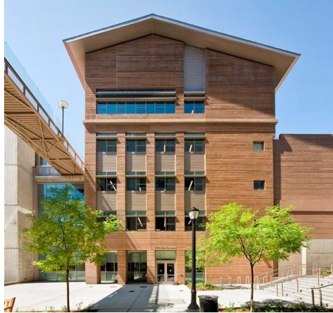
Figure 1: Façade Est du bâtiment Sutardja Dai Hall de l'Université de Berkeley
