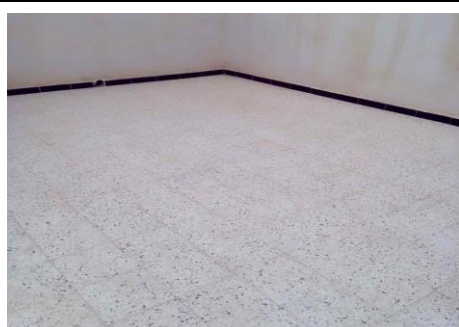
Revêtement en carrelage simple
