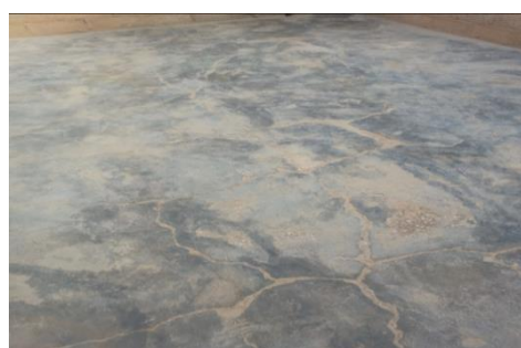
Revêtement en chape de ciment
